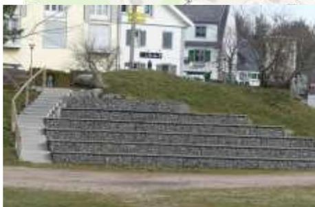
L2 : Gradins en gabions + bois, l'escalier est en béton
